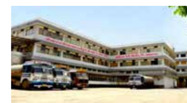
Sarvottam Dairy, Bhavnagar工場
