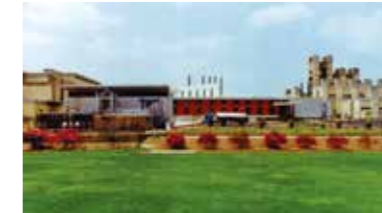
Dudhsagar Dairy, Mehsana工場
